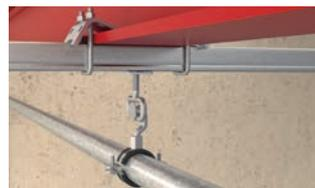
Montageschiene an Stahlträger: TKR, FUS Montageschiene
