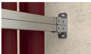
Wandanschluss Rahmenkonstruktion: SF82, FUS 41D
