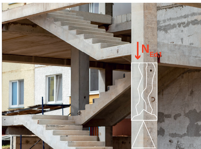
Abb. 6 – links: unverstärkte Stütze, rechts: umschnürte Stütze
