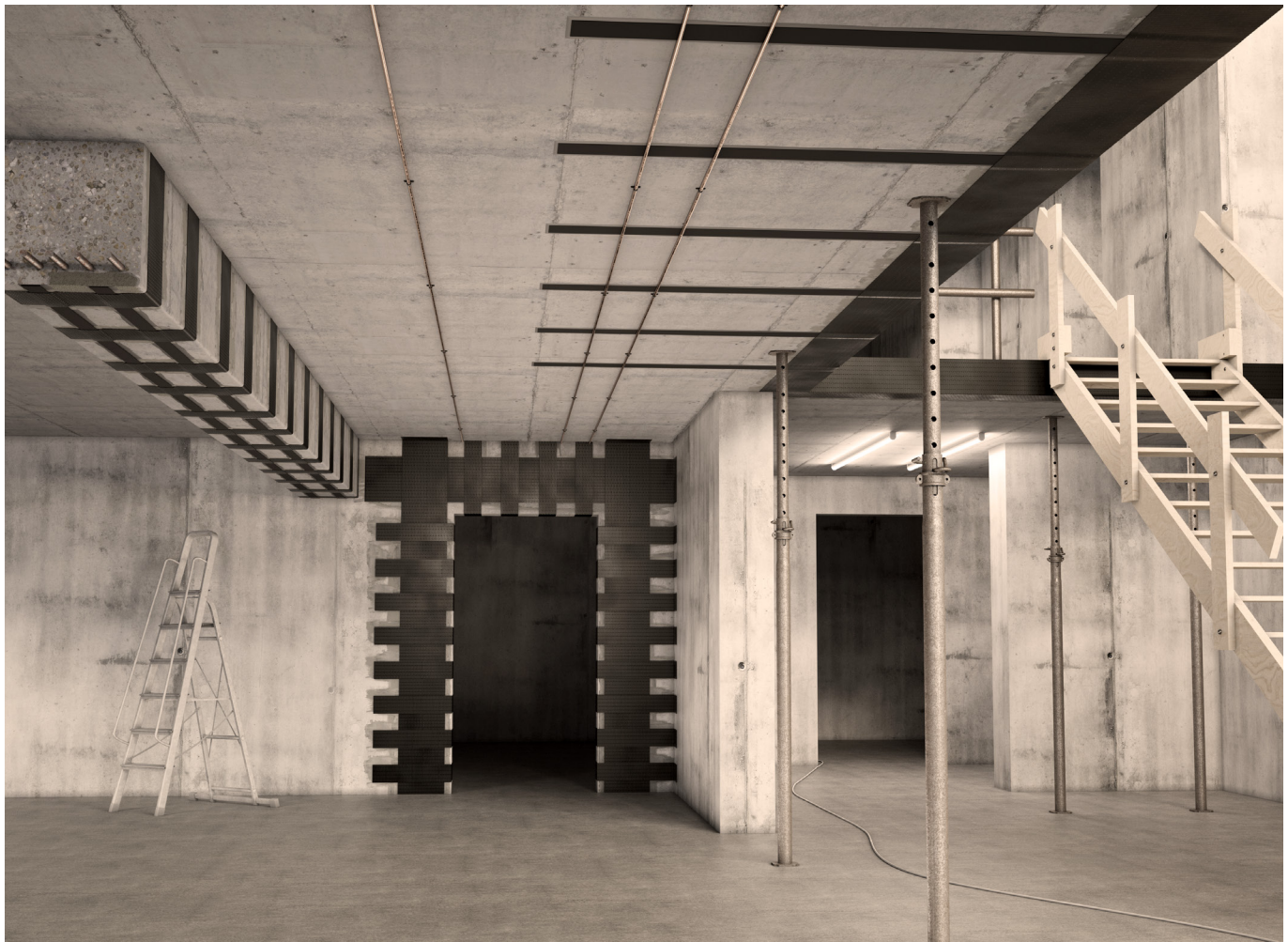
Abb. 1 – Gebäude mit Biege- und Querkraftverstärkung
