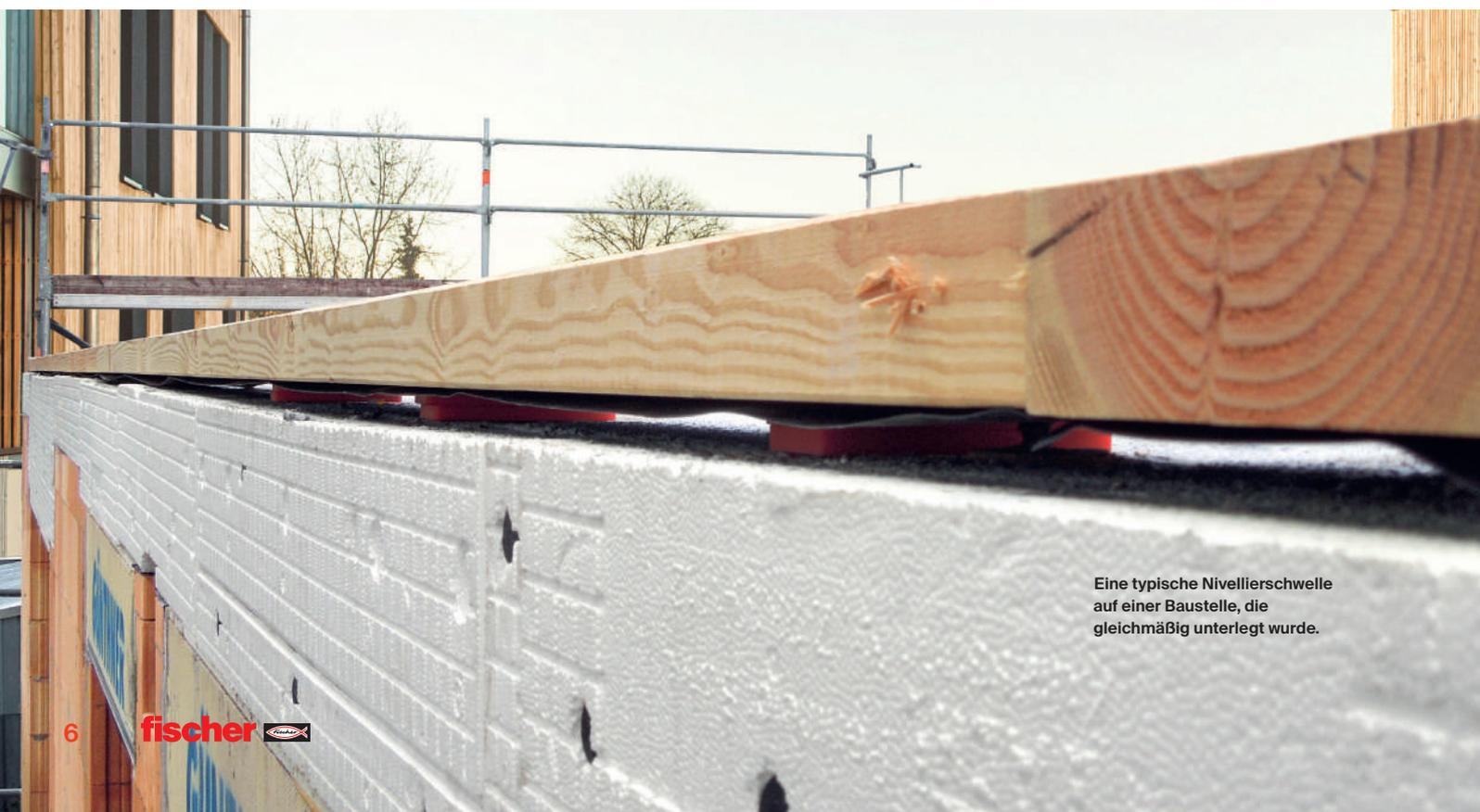
Eine typische Nivellierschwelle auf einer Baustelle, die gleichmäßig unterlegt wurde.
