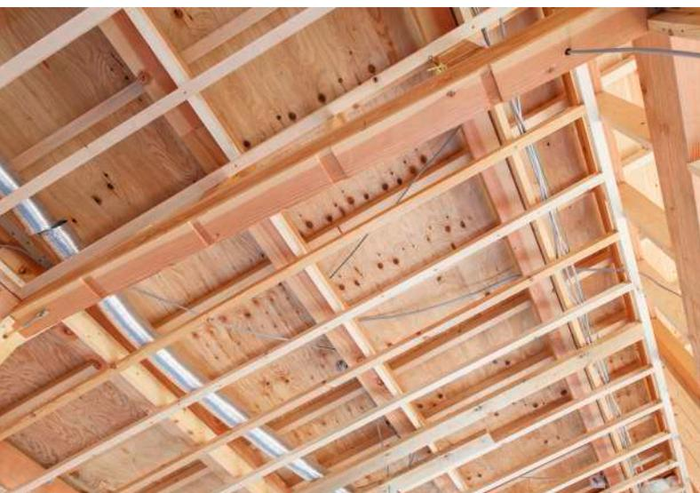
Eine Unterkonstruktion aus Holzlatten beim Dachausbau.
