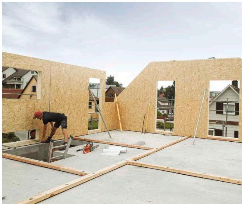
Die Holzwände lassen sich daraufhin zügig montieren.
