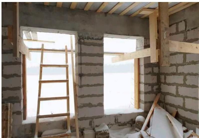
Eine Unterlattung aus Holz an einer Betondecke.
