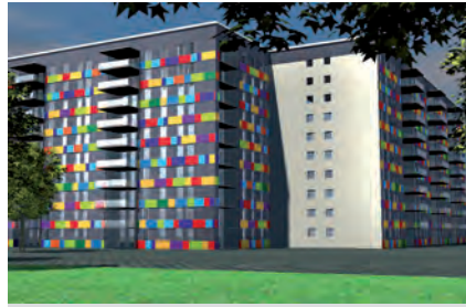
Sanierung von Wetterschalen
