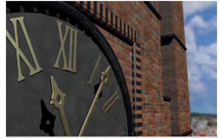
Sanierung von Vormauerschalen
